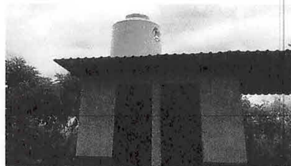
Foto 12: Instalación de tanque elevado Rotoplas de 1,200 litros.
