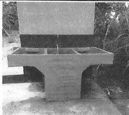
Foto 4: Colocación de Pila de Concreto nueva.
