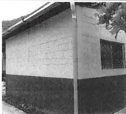
Foto7: Colocación de Pintura en Establecimiento Interior y Exterior
