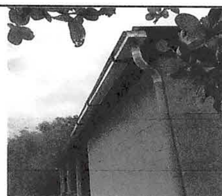
Foto 10: Instalación de Canales y bajada de aguas.
