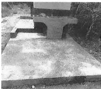
Foto 3: Reconstrucción de Torta de Concreto para colocación de Pila de 4.50 M2 X .10 cm de espesor.
